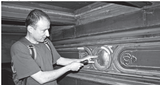
Na dřevěném kazetovém stropě v hlavní síle synagogy budou obnoveny také symboly šesticípých hvězd, které byly odstraněny v roce 1938 a dnes jsou z nich vidět jen obrysy, jež na snímku ukazuje Jan Stejskal z občanského sdružení Krnovská synagoga.
